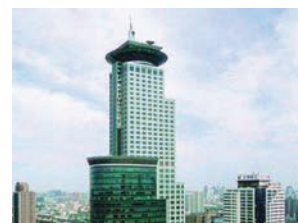
上海国际航运大厦
